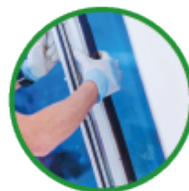
Remplacement des fenêtres
