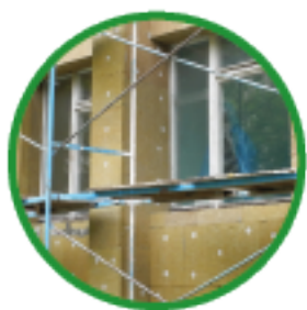
Isolation des murs ITE
