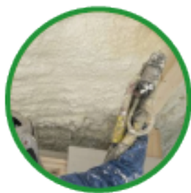
Isolation des planchers bas
