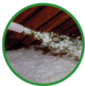
Isolation des combles perdus
