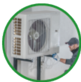
Isolation de pompe à chaleur
